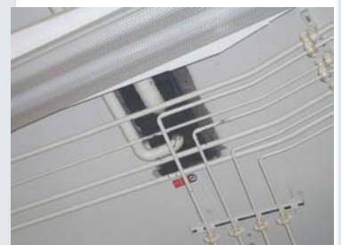
Asbesthaltige Deckendurchführung
