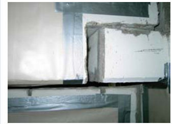
Entfernte Fugendichtmassen
