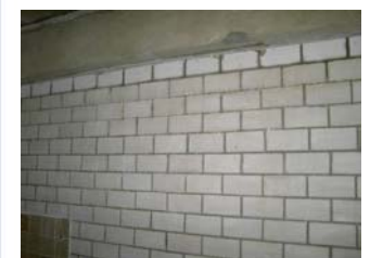
Sichtmauerwerk nach Demontage Wandfarbe mit WOMA-Verfahren (verminderter Wasserdruck) mit Einsatz von Abbeizer
