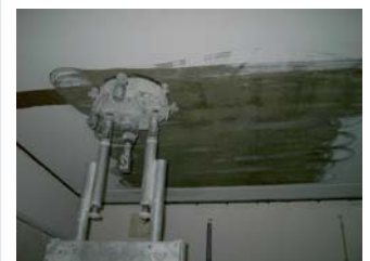
Demontage Farbe auf Beton-decke mit WOMA-
