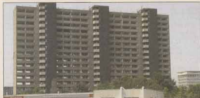
Dies ist die beste Sicht auf den (bereits entkernten) Goliath. Es ist die Brücke der Herzlia-Allee über die Eisenbahn (Bosch) kurz vor der Hauptkreuzung Herzlia-Allee/Bergstraße. Rechts ein Rathausurm. FOTO: WERNER KADDOCH
