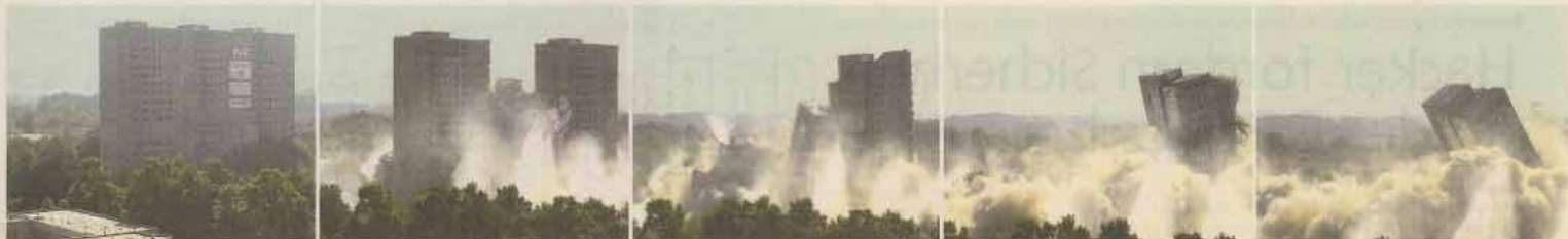
Goliaths letzte Sekunden: Vom Dach des Rathauses war der „Rückbau“ des höchsten Gebäudes in Marl gut zu erkennen. Würgerruß sahte zuerst der mittlere Teil in sich zusammen. Ein Teil des Treppenhauses blieb aber länger stehen als von den Sprengtechnikern berechnet. (Bild 3) Es flüzte laut Plan noch vor dem rechten Gebäudedrittel am Boden sein sollen. Probleme bereitete dieser letzte Widerstand aber nicht. Der dritte Turm, effektiv gefällt wie ein Baum, zermalmte alles, was ihm beim Niedergang in die Quere kam. Foto: Ulrich Zimmern
