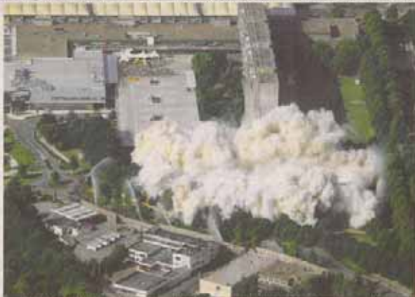
Aus 800 Meter Höhe: Marls höchstes Wohnhaus versinkt in einer Staubwolke und Tausende schauen dabei zu. Foto: WAZ, Hans Blossey
