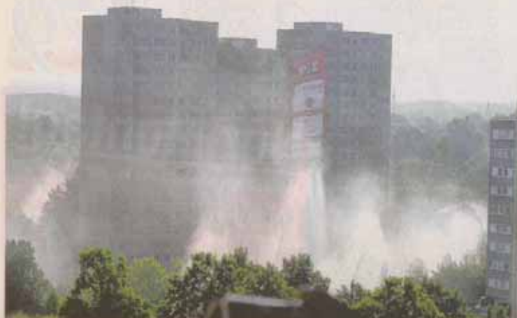
Blick vom Rathaus-Turm: Die Mitte des Goliath hat einen Knacks weg ...
